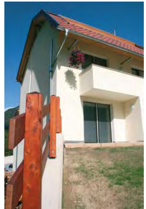
Unten: Das neue Zweifamilienhaus, das den Platz des alten Gasthofes Bad Salt einnimmt
